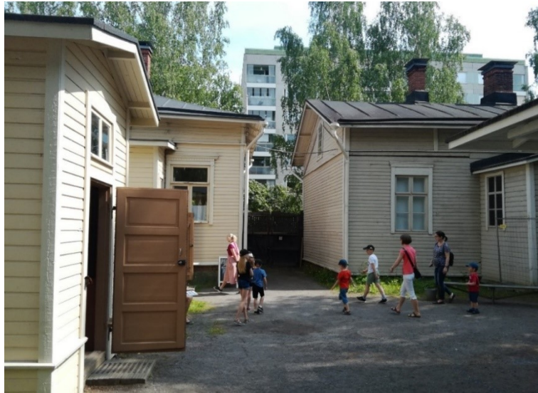
Kuva 11: Näkymä Amurin työläismuseokorttelin sisäpihalta. Taustalla on Amurinkujan vuonna 1971 rakennettu elementtikerrostalo.
